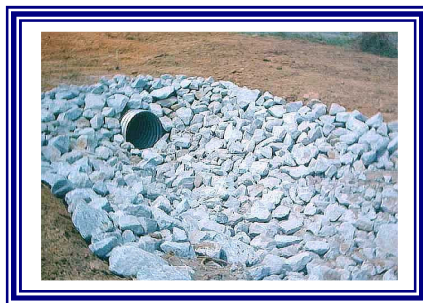
Riprap Outlet Protection
