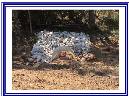
Riprap Outlet Protection
