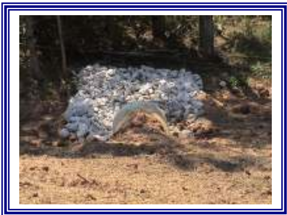
Riprap Outlet Protection
