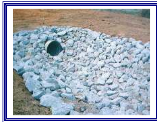
Riprap Outlet Protection
